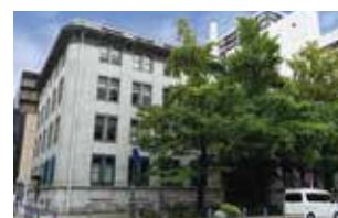
●三井物産横浜ビル（1911年竣工） 日本最古のRCオフィスビル。 100年以上経過した現在も現役。
