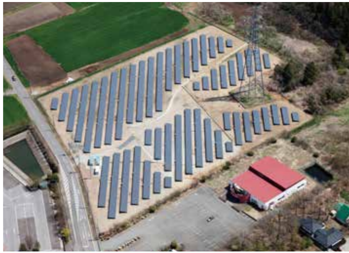
〔産業用太陽光発電設置事例〕 施工: 株式会社シーサービス ●所在地: 栃木県那須郡 ●物件概要: 野立て ●方式: 全量買取 ●完成: 平成26年3月 ●出力: 1397.76kw
