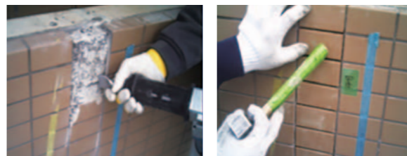
タイル張替工事
