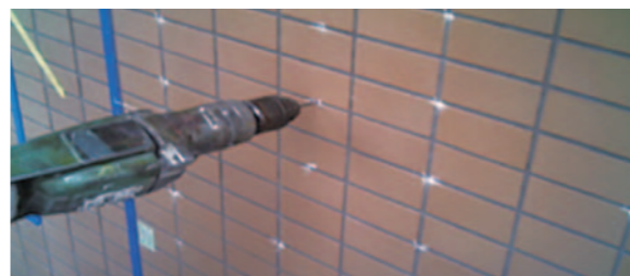
下地補修工事
