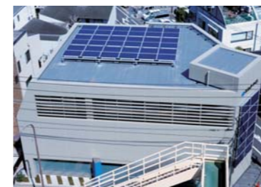
▲屋上設置用 太陽光発電パネル
